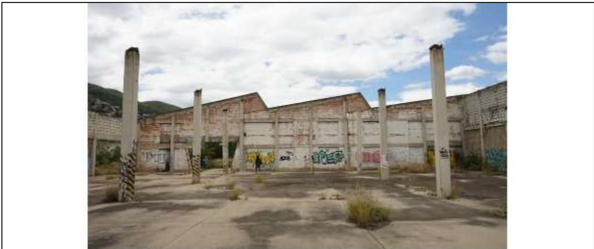
Área en malas condiciones, con el concreto destruido y presencia de maleza.
